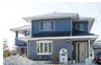
内装のリフォームに合わせて外装もリフレッシュ。外塀や門塀は曲線で柔らかくデザイン
