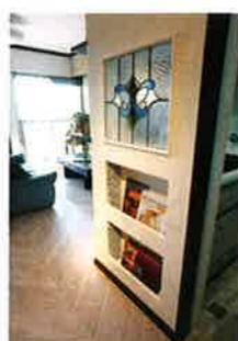
④ キッチンの仕切り壁の厚みを利用し、タイル仕上げのお洒落で便利なブックシェルフを造作
