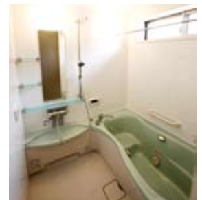
⑥入浴中シルエットが外から見えないようスリット窓を高い位置に設置
